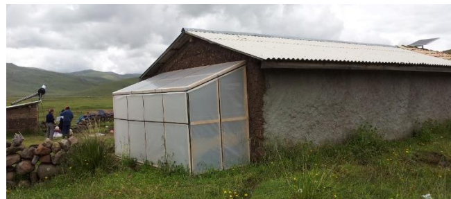
Figura 3: Sistema de calefacción solar
