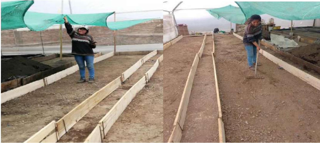
Figura 1. Instalación y nivelado de los contenedores
