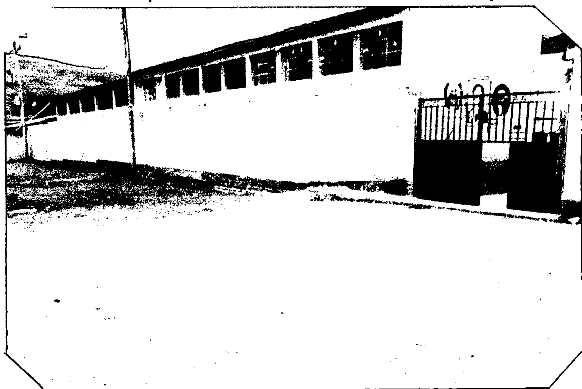
Parte exterior del C.E.A.I. "Víctor Andrés Belaunde" San Pedro de Cajas-Tarma.
