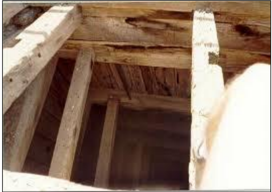
Figura 2.2 Pique rectangular con sostenimiento de madera
