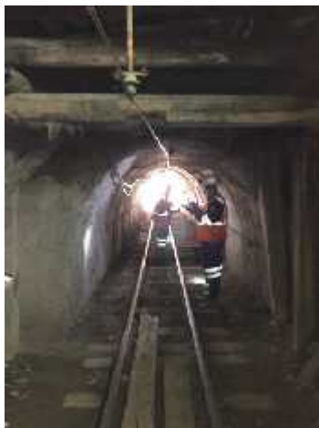
Figura 15. BM túnel Potosí II de CMCSA.
