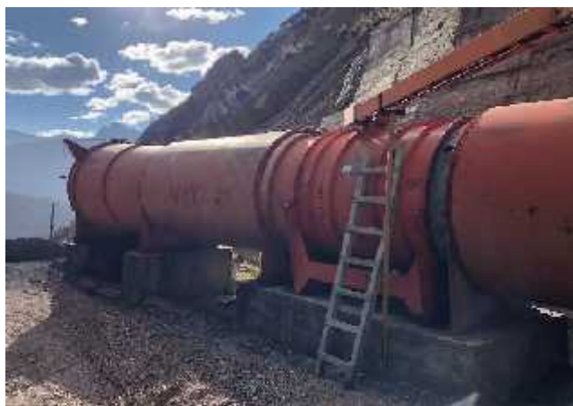
Figura 18. Ventilador principal de 150 000 cfm en RB 593 Y RB 600 de CMCSA.
