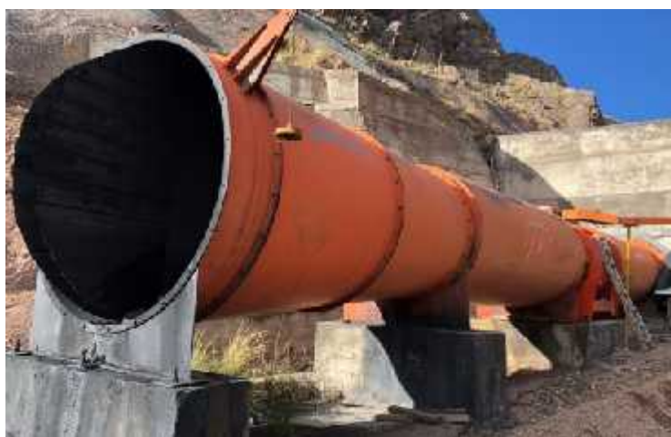
Figura 29. Ventiladores principales COD 100 de CMCSA.
