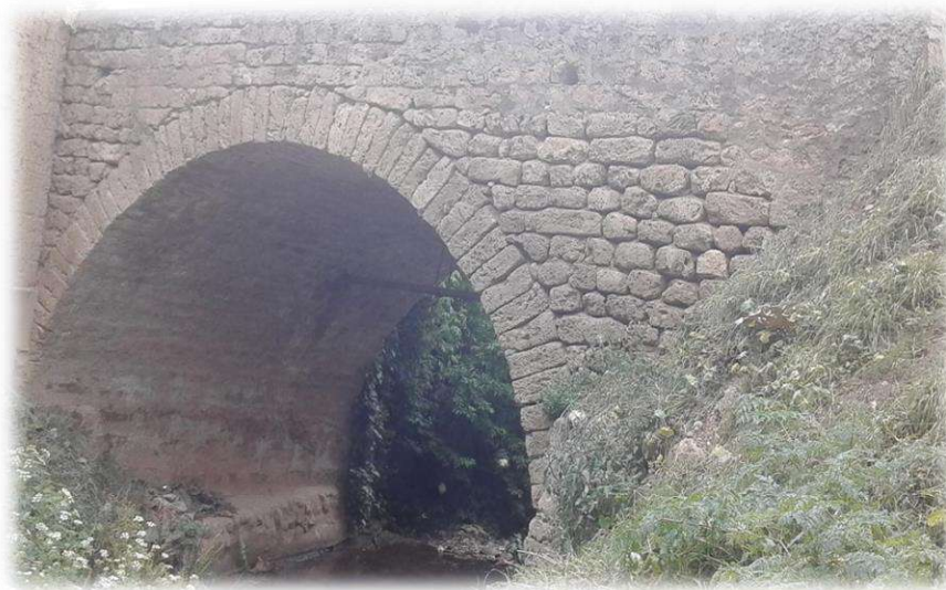
Figura 40. Construcción del Puente Calicanto
