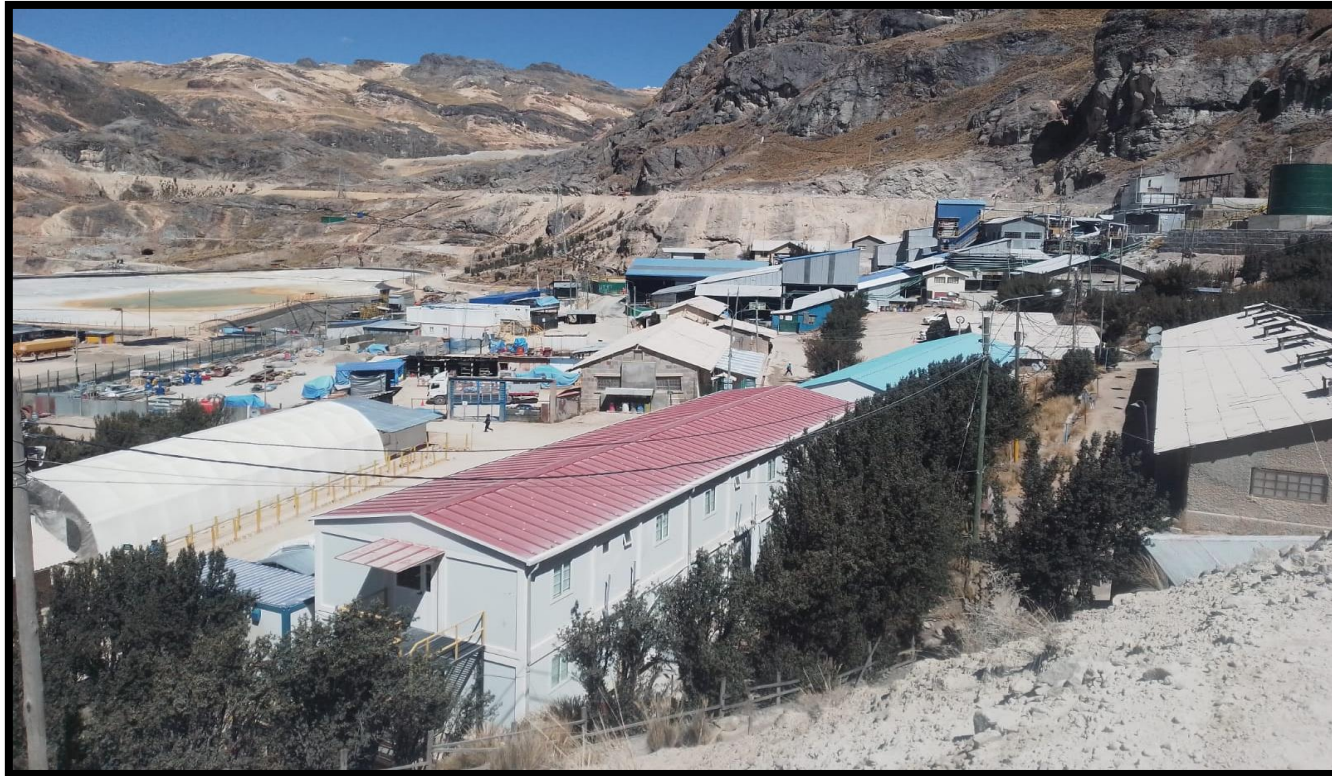
Planta Concentradora Kolpa
