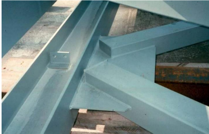
Figura 2.2: Unión soldada de diagonales con cartela
