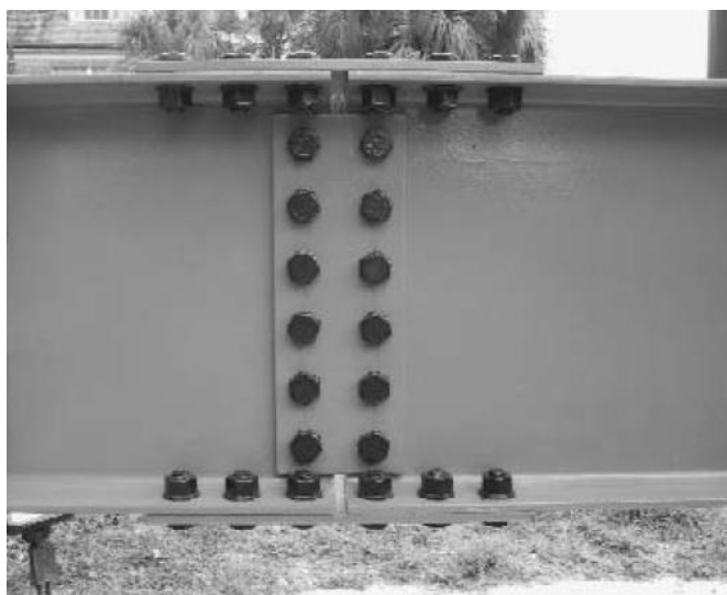
Figura 2.1: Conexión apernada, empalme a momento
