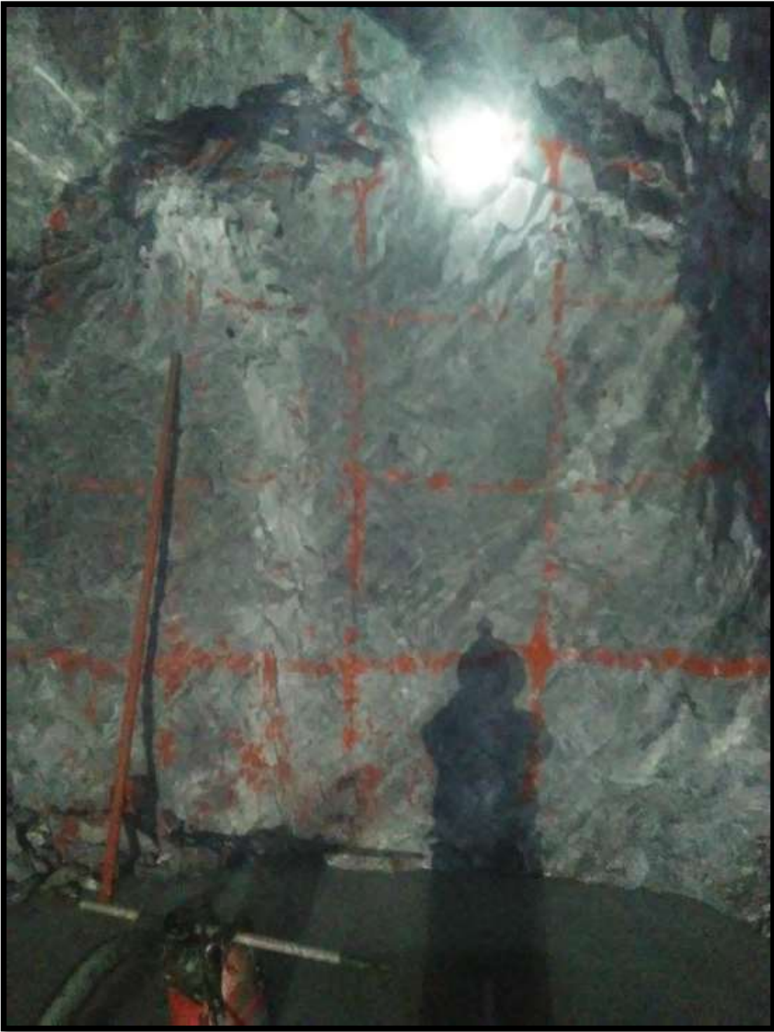
PINTADO DE MALLA TENIENDO ENCUESTA PUNTO DIRECCION Y PUNTO GRADIENTE
