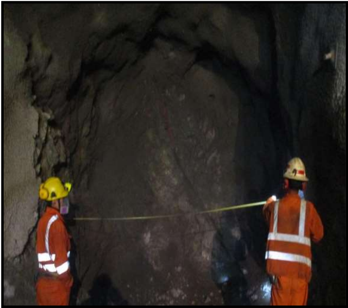
MIDIENDO LA SECCION DE LA LABOR CON EL COLABORADOR
