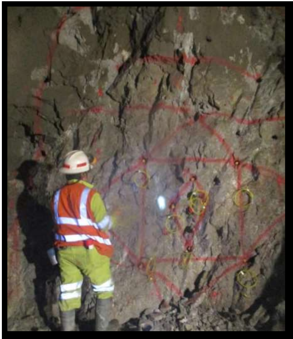
FIGURA 3. DISTRIBUCION DE EXPLOSIVOS EN UN FRENTE
