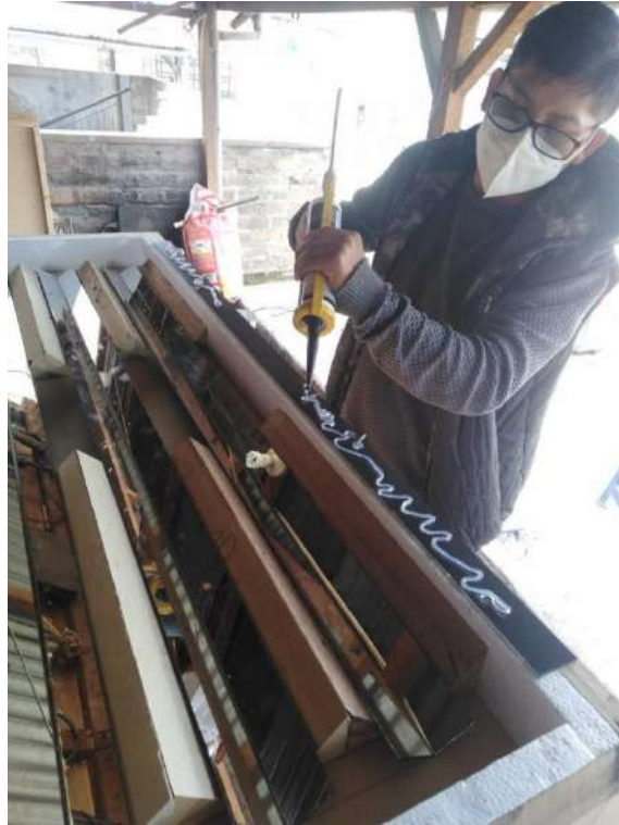
Sellado y aseguramiento de estructuras reflectantes
