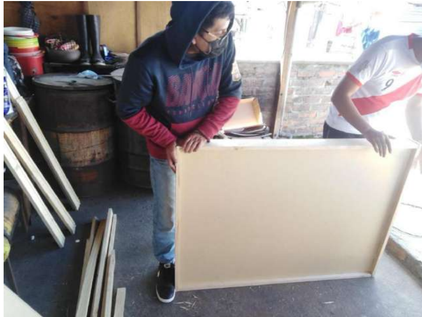
Preparación de la base del colector solar
