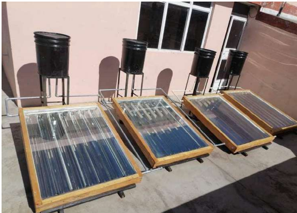
Colectores solares finalizados
